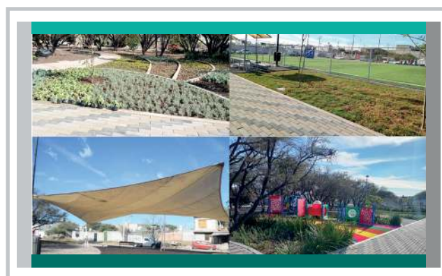
Figura 2 Obra concluida de la rehabilitación del parque de Jardines de Jurica, producto del ejercicio de Gobierno Abierto en dicha colonia
